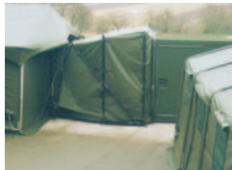
Eine typische Verbindungsschleuse zwischen Einheitszelt II (mit Sonnensegel) und einem Container.
