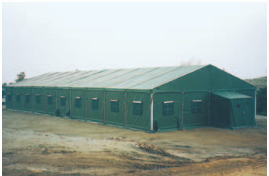
Betreuungszelt ohne Sonnensegel, mit geöffneten Fenstern und Anschlüssen für Heizung und Lüftung.
