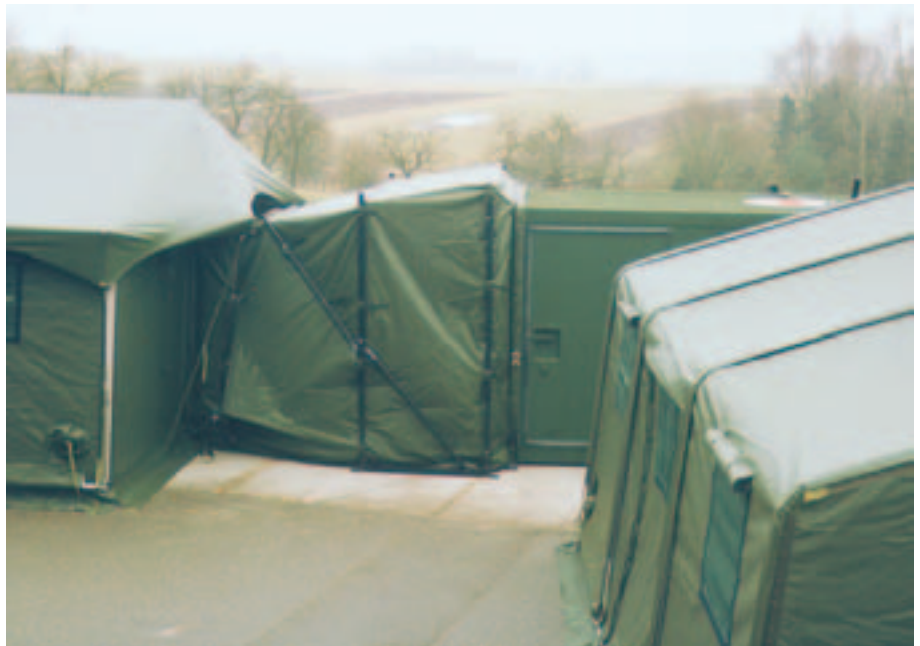
Eine typische Verbindungsschleuse zwischen Einheitszelt II (mit Sonnensegel) und einem Container.
