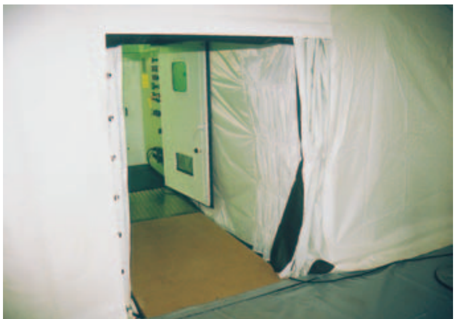
Innenansicht einer Verbindungsschleuse, die das Einheitszelt II und die Eingangstür eines Containers verbindet.
