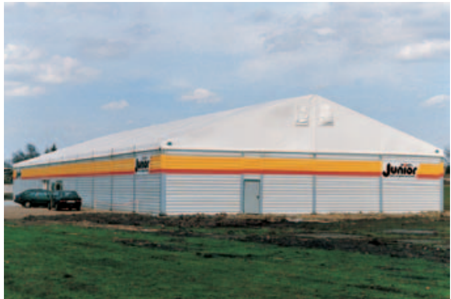
Lagerzelt mit Seitenwänden aus Kunststoff-Trapezplatten, seitlicher Haupteingangstür und stirnseitigem Notausgang.
