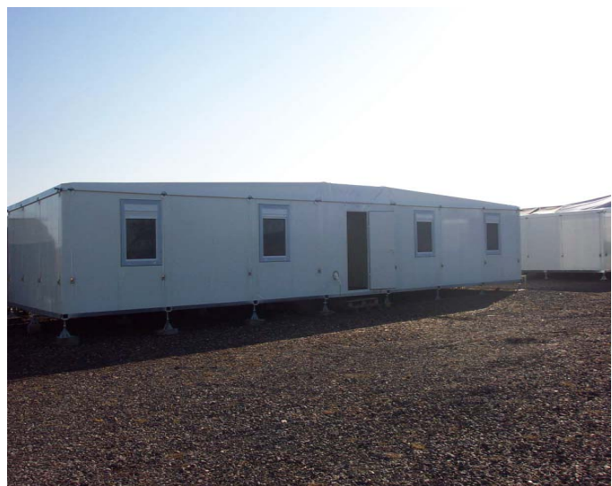
Beispiel: 3er-Module mit Zwischengang
