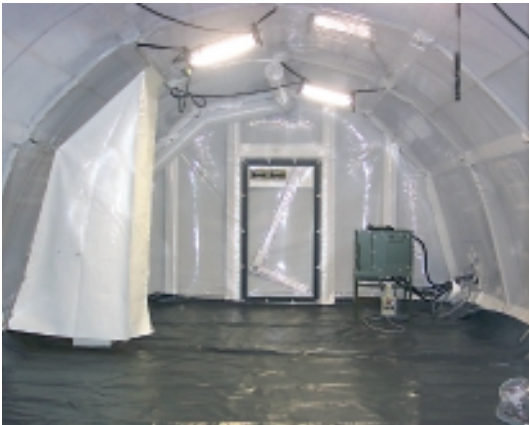
Colpro-Kabine, welche als Option für die unterschiedlichen Schall-Zelttypen diese in einen ABC-Schutzraum umwandeln
